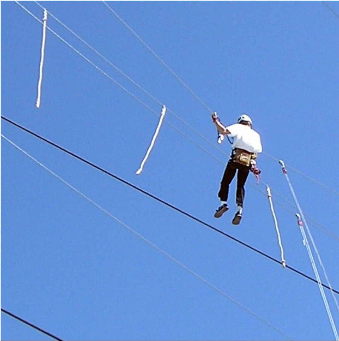
Inspektion und Gutachten
